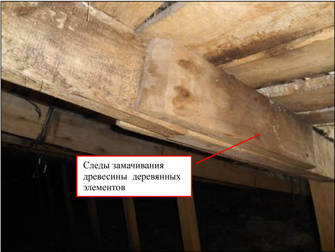
Рис. 9 Фрагмент стропильной системы
