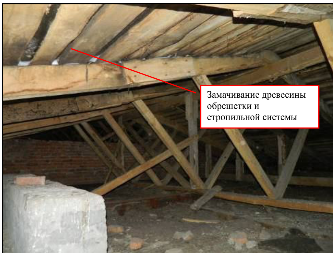
Рис. 14 Фрагмент стропильной системы
