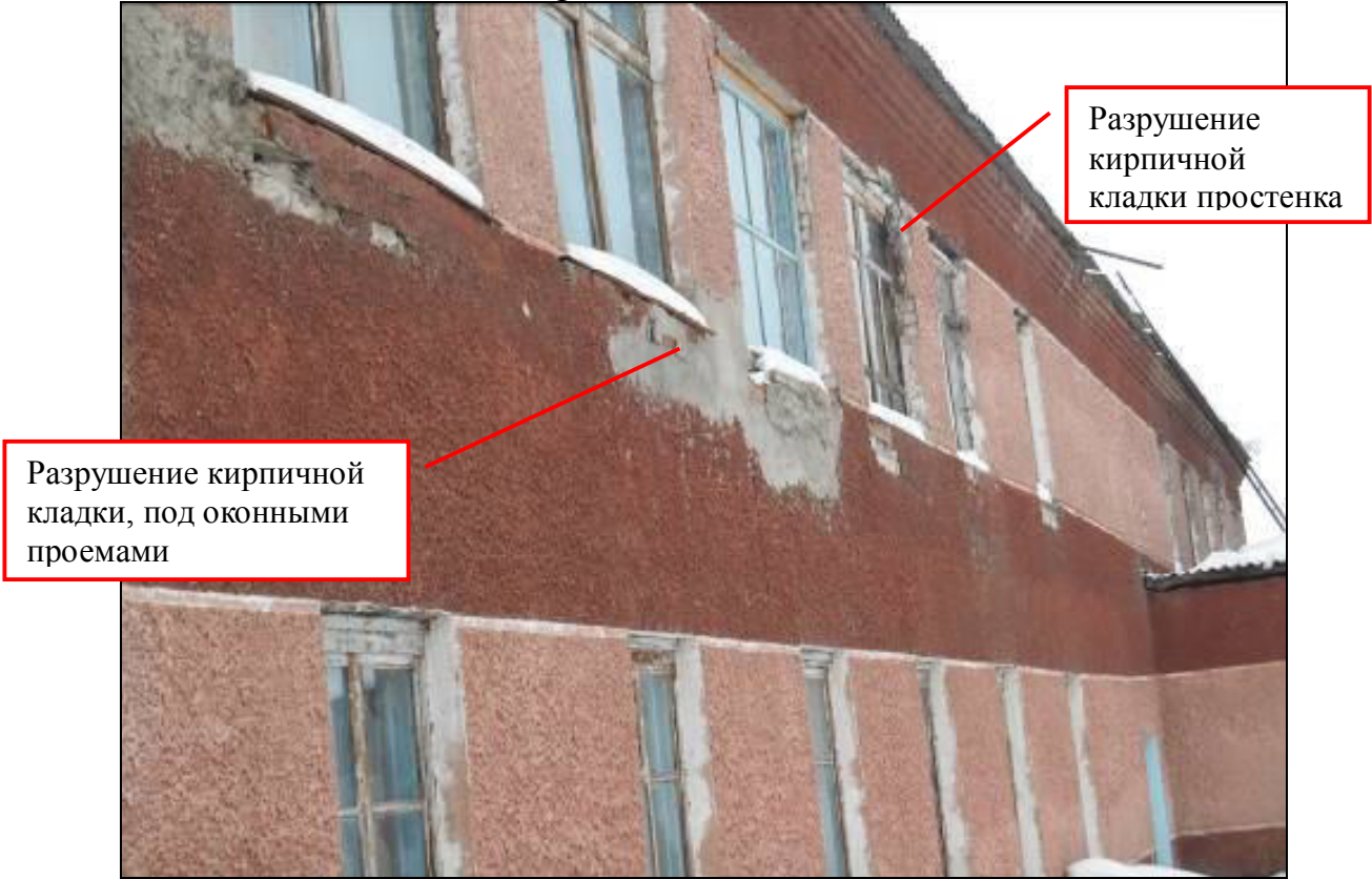
Рис. 1 Фрагмент стены по оси «Г»
