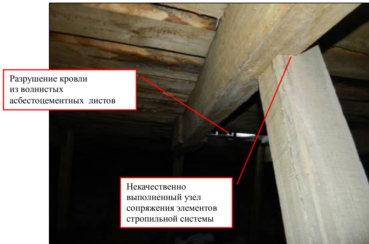
Рис. 14 Фрагмент стропильной системы
